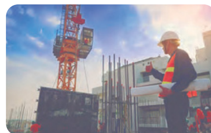
NR 18 Seg. e Saúde no Trab. na Ind. da Construção
